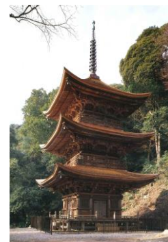
小山寺三重塔
