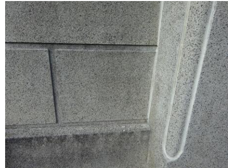
人造石洗出し仕上げの外壁
