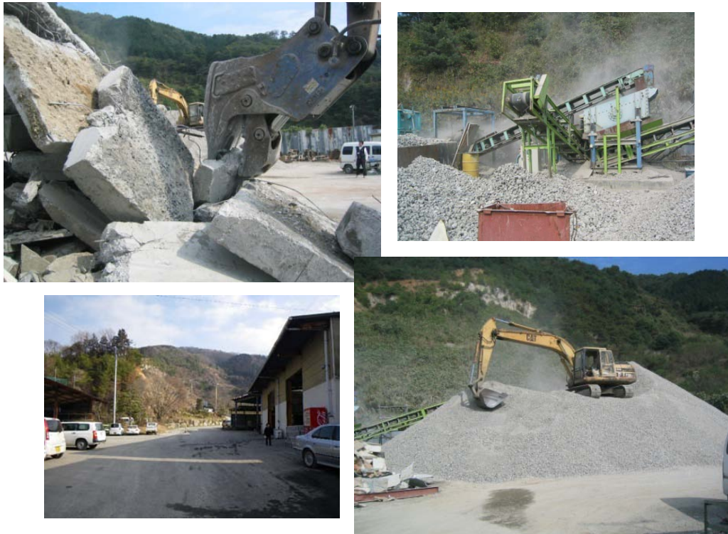
廃コンクリートを破碎し、路盤材などへ再生される
