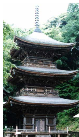
小山寺三重塔
