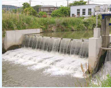
改修された青木堰
