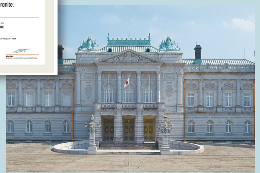
国宝の迎賓館赤坂離宮(1909年)の外壁には 真壁石が使用されています
