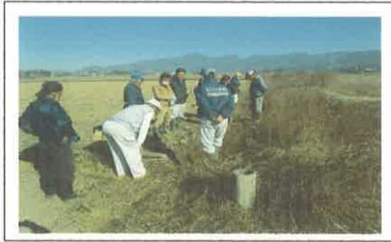
水路法面の軽微な補修 【共同活動】
