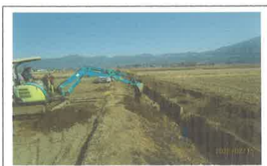
用水路、法面補修工事 【長寿命化活動】
