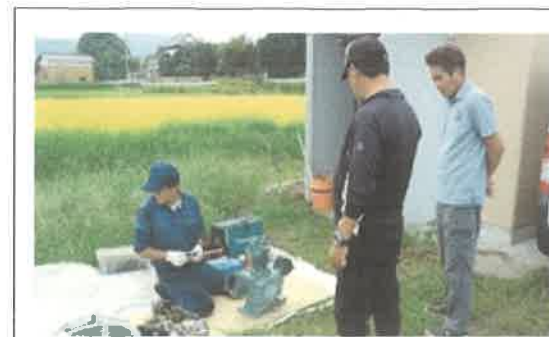
青木堰コンプレッサーオーバーホール 【長寿命化活動】
