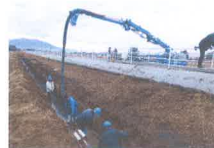
長寿命化 排水路補修工事
