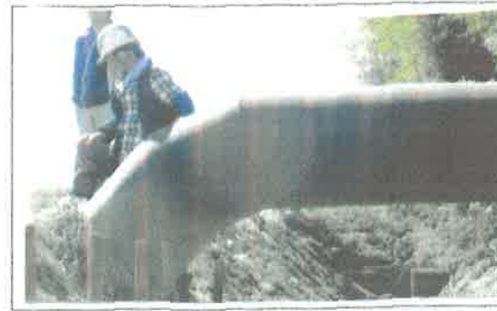
水路の更新工事 【長寿命化活動】
