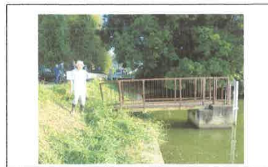
莫大沼水門フェンス修理 【長寿命化活動】
