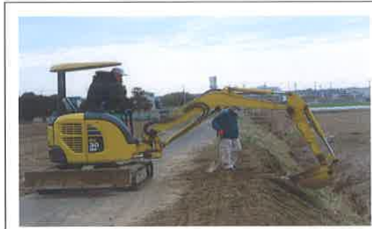
道路法面の補修 【共同活動】
