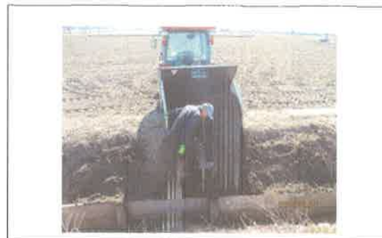
（例）水路の軽微な補修 【共同活動】
