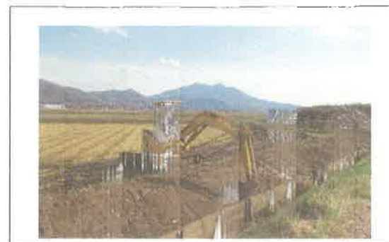
（例）水路の更新工事 【長寿命化活動】
