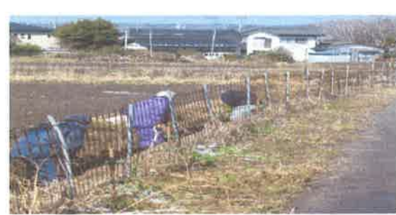
排水路の土砂あげ 資源維持(維持管理)】
