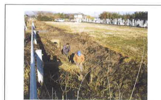
水路の泥上げ、補修 【共同活動】
