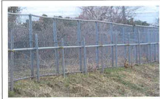
機場フェンス倒伏箇所補修補強 【長寿命化活動】
