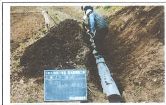
水路補修工事 【長寿命化活動】
