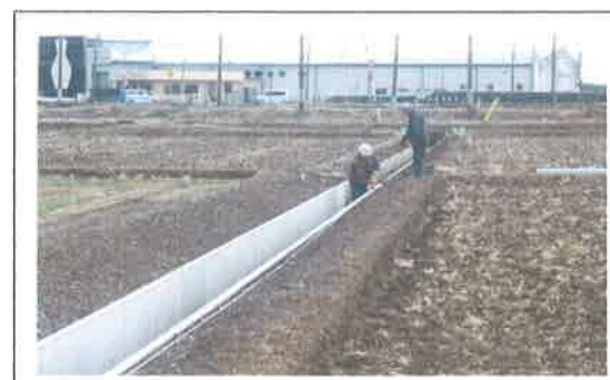
水路の更新工事 【長寿命化活動】
