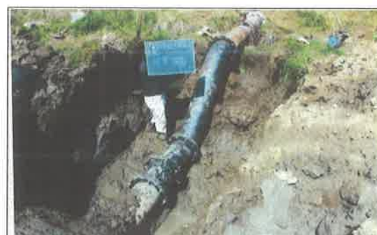
配水管漏水改修工事 資源向上 (長寿命化)】
