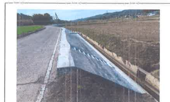
水路の補修工事 【長寿命化活動】
