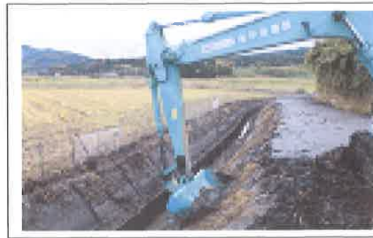
柵渠土砂払い及び練面整正工事 【長寿命化】
