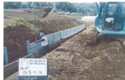
水路の底板コンクリート工事 【長寿命化活動】
