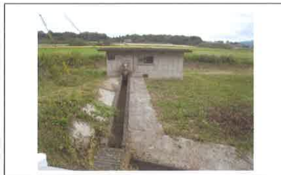
水路の軽微な補修 【共同活動】
