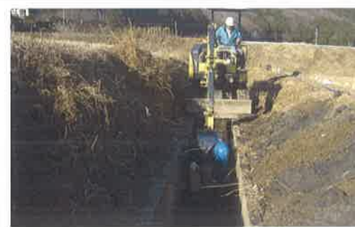
柵渠底版コンクリート工事 【長寿命化活動】
