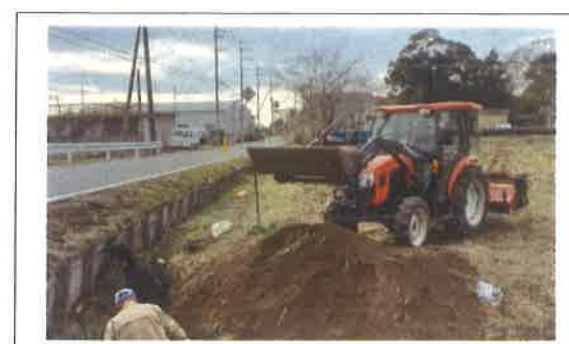
水路の底版工事 【長寿命化活動】
