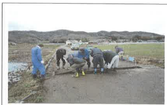
水路の軽微な補修 【共同活動】
