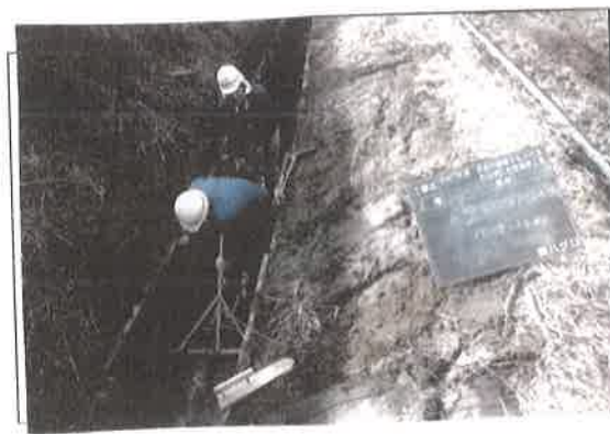
排水路の底版打設工事 【長寿命化活動】
