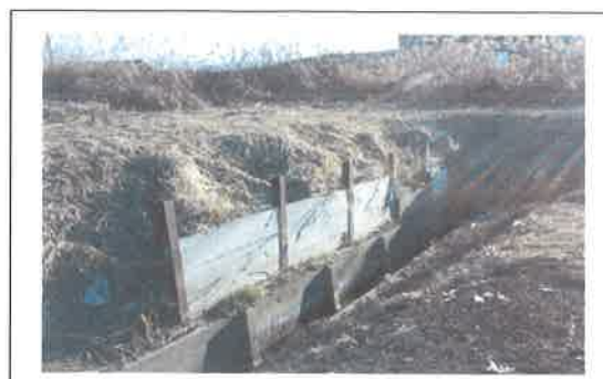
水路の軽微な補修 【共同活動】
