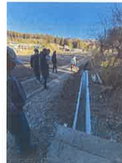
水路の更新工事 【長寿命化活動】
