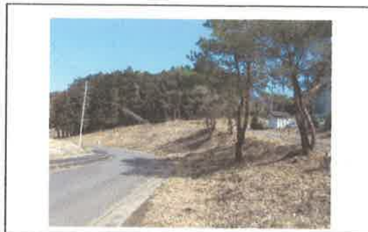
法面の整備 施工後 【共同活動】
