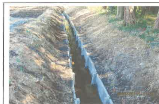
水路の更新工事 【長寿命化活動】
