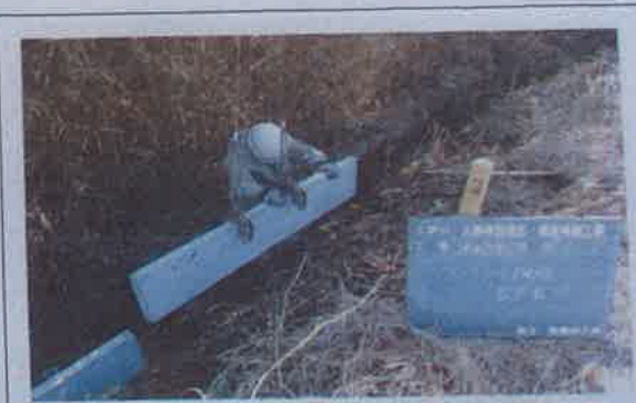
水路の柵渠工事 【長寿命化活動】
