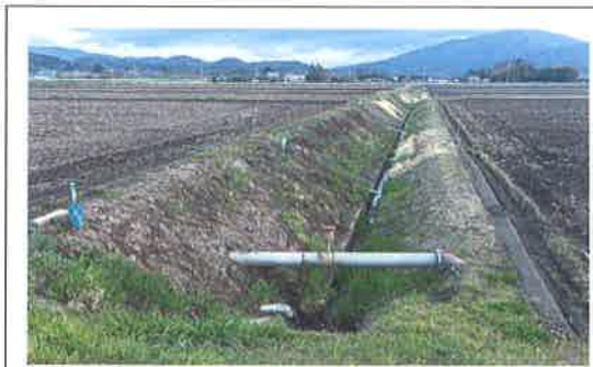
法面補修工事 【長寿命化活動】
