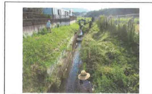
水路の補修 【長寿命化活動】
