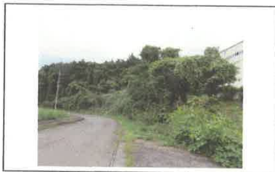
法面の整備 施工前 【農地維持活動】
