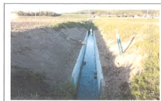
水路の更新工事 【長寿命化活動】
