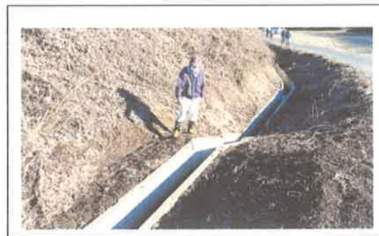
水路の補修工事 【長寿命化活動】
