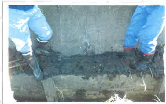
水路の軽微な補修 【共同活動】
