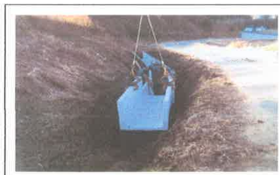
水路の更新工事 【長寿命化活動】
