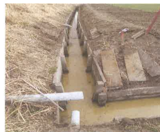
水路の改修工事 【長寿命化活動】
