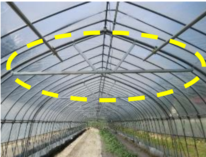
タイバーの設置による補強
