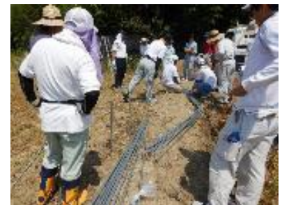
災害復旧の取組実証
