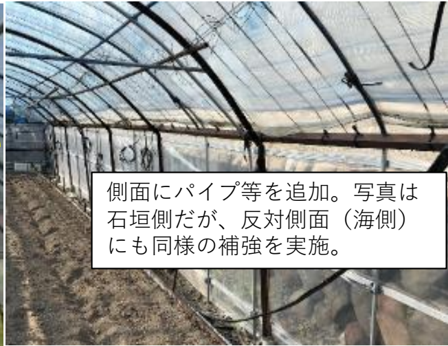
側面の補強（強風対策）
