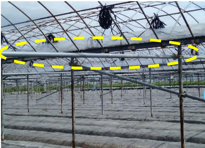
タイバーの設置による補強
