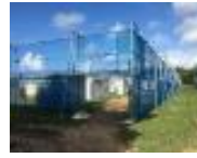
防風ネットの設置
