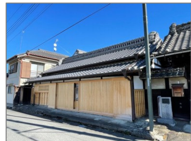
村上家主屋修理 （伝統的建造物）
