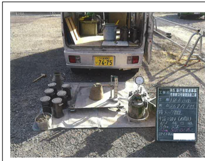
生コンクリート現場試験
