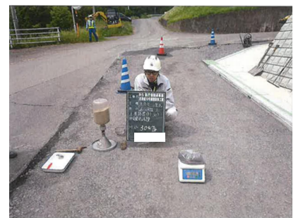
現場密度試験
