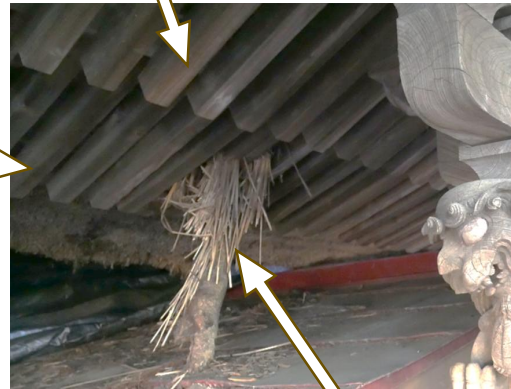
倒木の枝が屋根を貫通し垂木も破損
