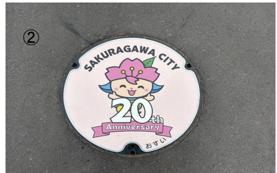
設置場所②大和駅北公園外周囲路(歩道側)
