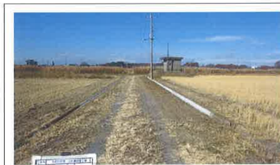
U字溝布設工事(第1機付近) 資源向上(長寿命化)
