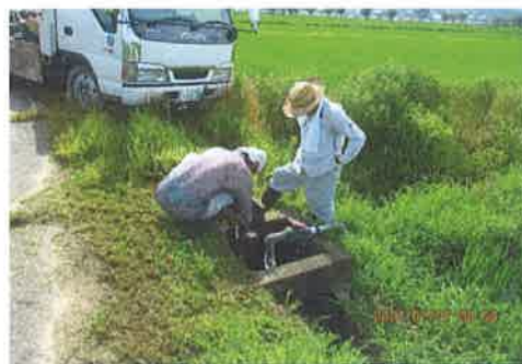
水路の軽微な補修 【共同活動】
