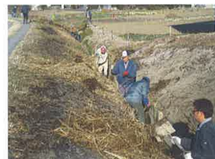
水路の泥上げ、補修 【共同活動】
