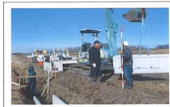
水路の更新工事 【長寿命化活動】
