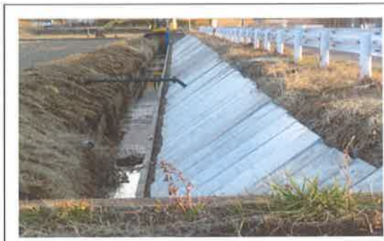
草刈り作業軽減と道路法面補強 の為にコンクリート板敷設
