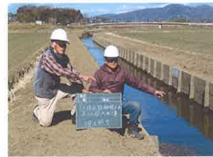
排水路コンクリート補強工事 【長寿命化活動】
