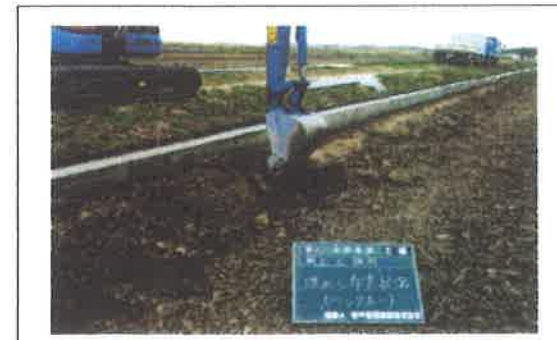
水路補修工事 【長寿命化活動】
