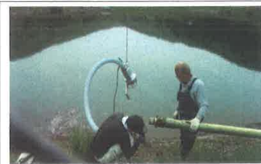
第5機場揚水ポンプ更新 資源向上（長寿命化）】
