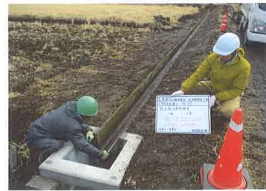
U字溝段差柵及び水路修繕工事 【長寿命化活動】
