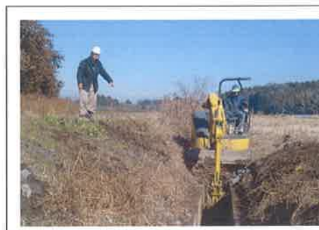
水路の破損補修工事 【長寿命化活動】
