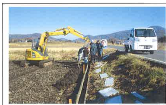
用水路、法面補修工事 【長寿命化活動】
