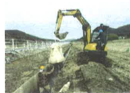
長寿命化 排水路補修工事
