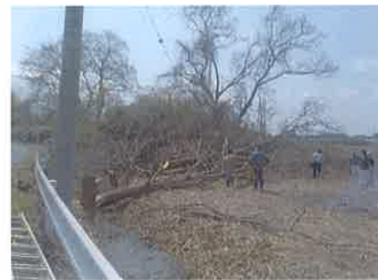
水路に掛かる樹木の伐採 【長寿命化活動】
