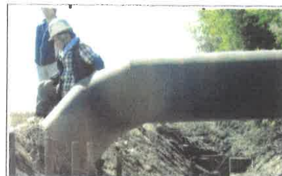
水路の更新工事 【長寿命化活動】
