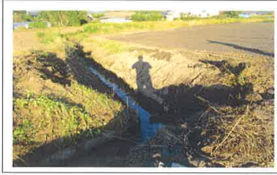
水路法面の軽微な補修 【共同活動】
