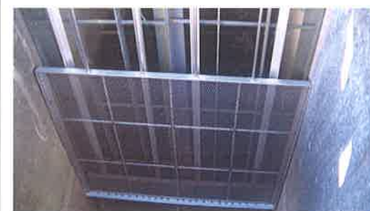
第一農場スクリーン工事 【長寿命化活動】
