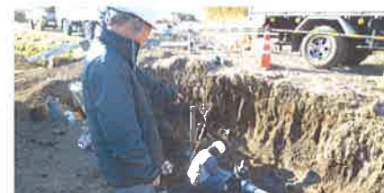
パイプラインの補修 【長寿命化活動】
