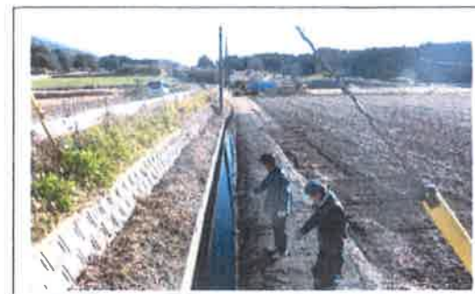
水路の更新工事 【長寿命化活動】
