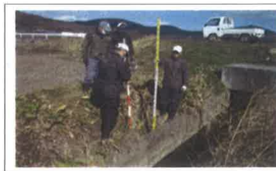
水路の更新工事 【長寿命化活動】
