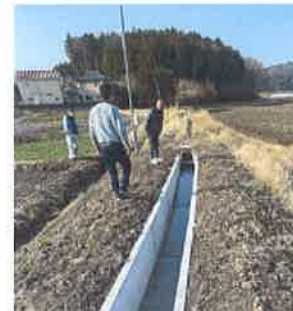
水路の更新工事 【長寿命化活動】
