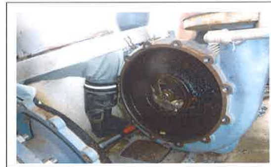
ポンプ異物分解修復 【長寿命化活動】
