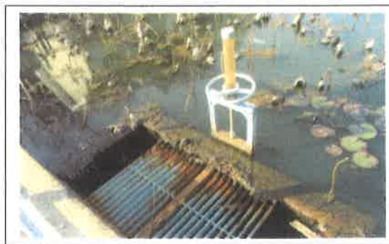
(例) 水路の更新工事 【長寿命化活動】
