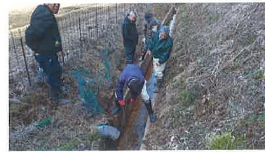
水路の更新工事 【長寿命化活動】
