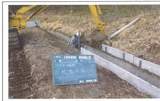
水路の柵渠工事 【長寿命化活動】
