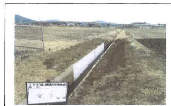
(例) 水路の更新工事 【長寿命化活動】
