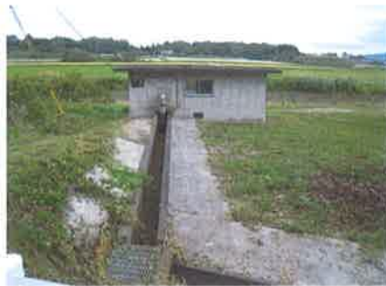
水路の軽微な補修 【共同活動】
