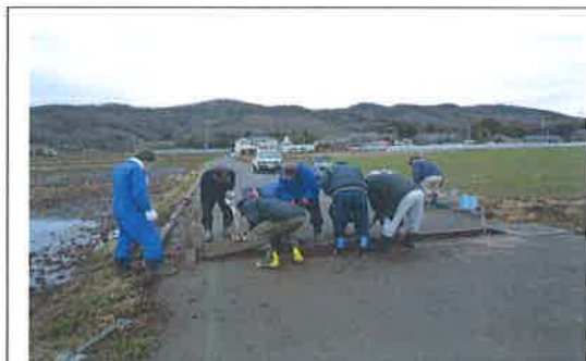
水路の軽微な補修 【共同活動】
