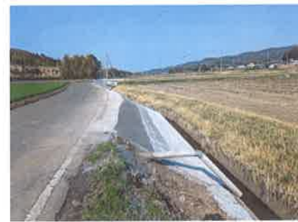
水路の補修工事 【長寿命化活動】
