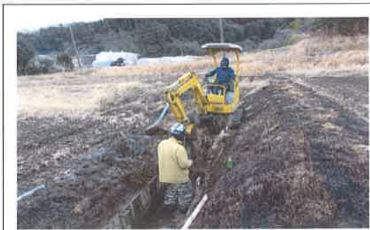
水路の更新工事 【長寿命化活動】
