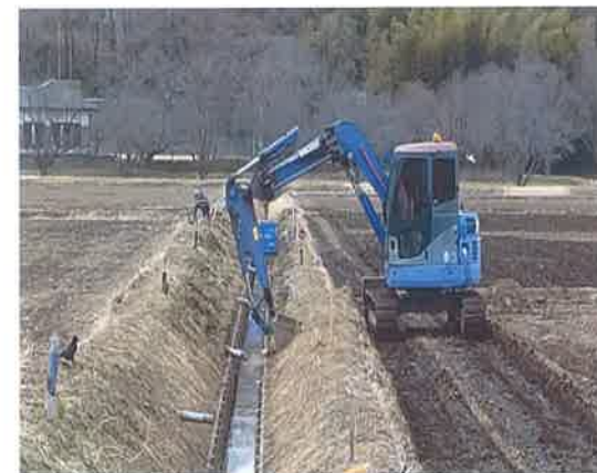
水路の改修工事 【長寿命化活動】
