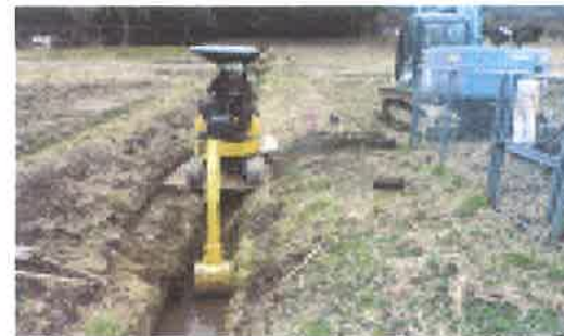
用排水路土砂掘削工事 【長寿命化】
