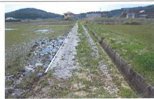
農道路肩土留め工事 【長寿命化活動】
