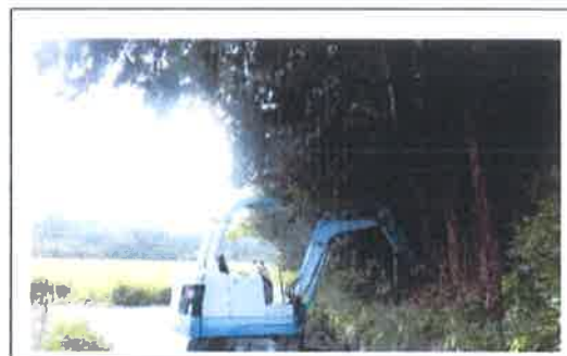
水路の軽微な補修 【共同活動】
