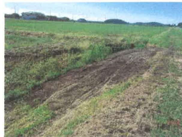
水路法面入口補修(トラクターによる草刈り) 【資源向上共同活動】
