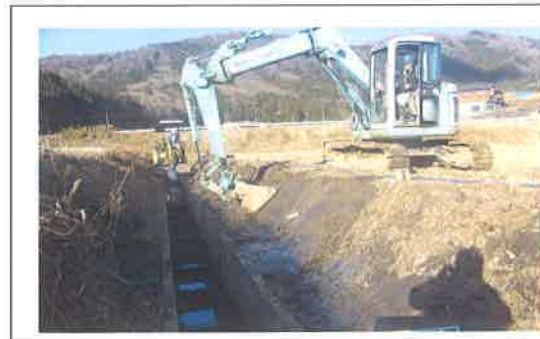
柵渠底盤コンクリート工事 【長寿命化活動】
