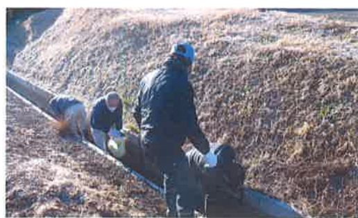
水路の軽微な補修 【共同活動】
