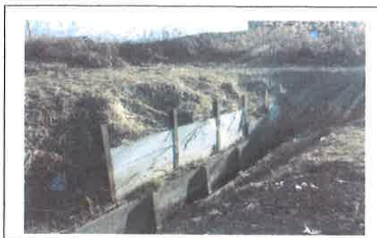
(例) 水路の軽微な補修 【共同活動】
