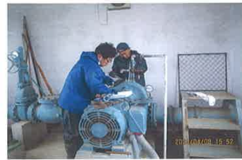
揚水ポンプ点検・整備 【長寿命化活動】
