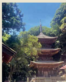
小山寺三重塔(富谷観音)
