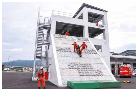
45度の傾斜壁を配置する山岳訓練施設
