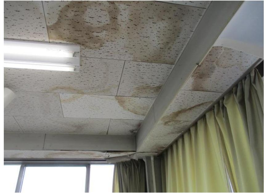
雨漏りによる天井雨染み
