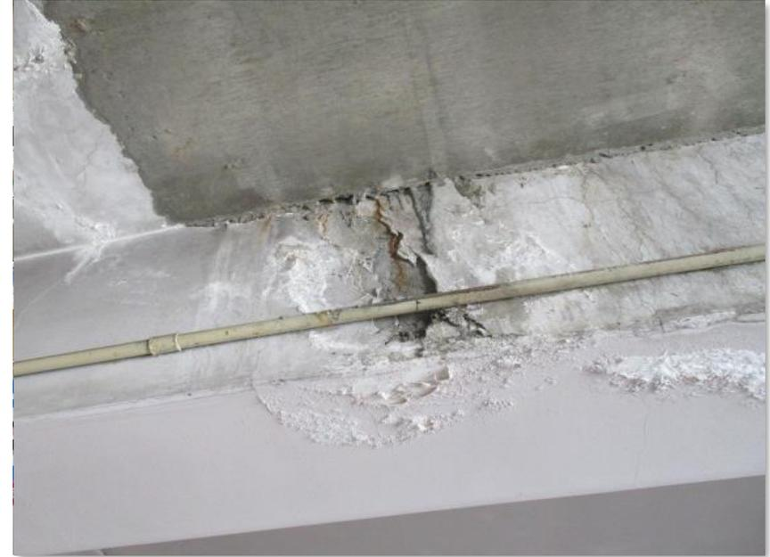
梁の欠損箇所、錆び汁
