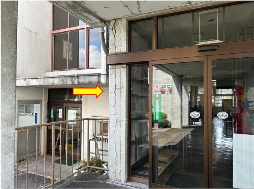
出入口柱の老朽化ひび割れ
