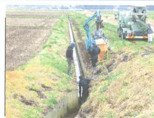
水路の補修 底版コンクリート打設 【長寿命化活動】
