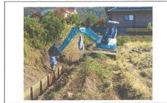
水路の泥上げ、補修 【長寿命化活動】
