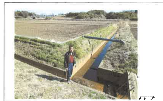
パイプラインの補修 【長寿命化活動】
