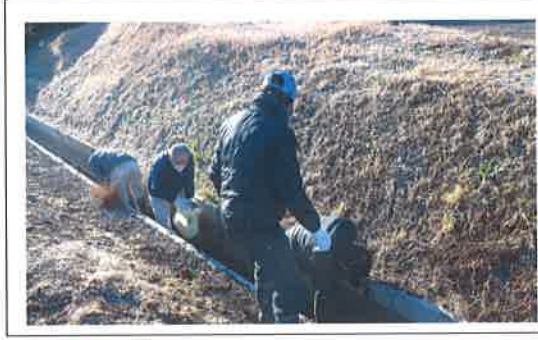
水路の軽微な補修 【共同活動】
