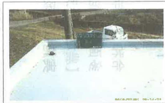
第1,2揚水機場防水シート張替 【資源向上 (長寿命化)】
