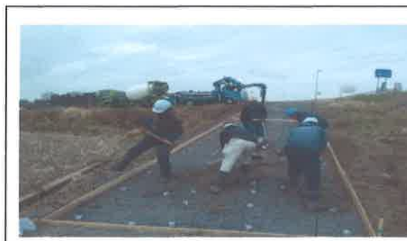
（例）農道の更新補修直営工事 【共同活動】
