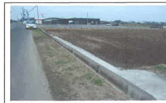
（例）水路の嵩上げ工事 【長寿命化活動】
