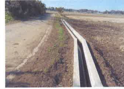
U字溝嵩上げコンクリート工事 【長寿命化活動】
