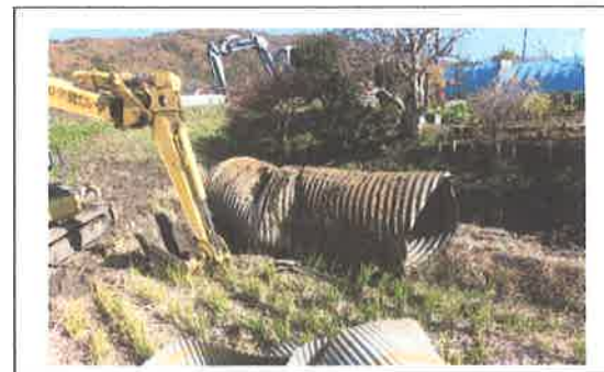
水路の更新工事 【長寿命化活動】
