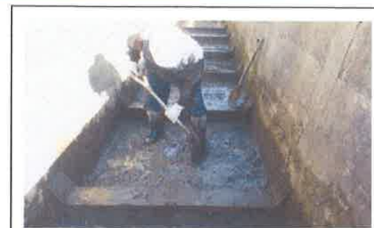
水路底盤の補修 【長寿命化活動】
