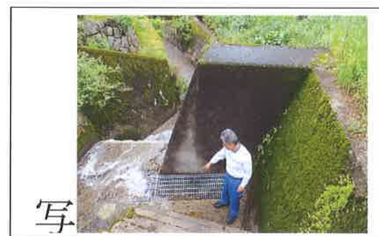
水路のグレーチング蓋取付工事 【長寿命化活動】
