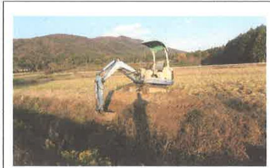
水路の軽微な補修 【共同活動】
