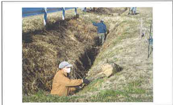
水路の泥上げ、補修 【共同活動】
