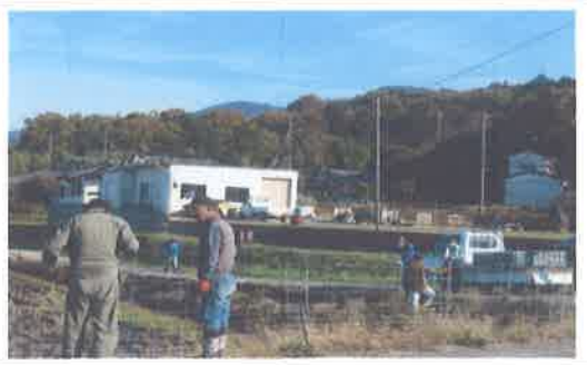
農用地、猪侵入防護柵設置作業 【農地維持活動】 11/19.20.27
