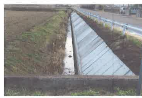
水路の法面コンクリートによる補強 【長寿命化活動】 2023.3.8
