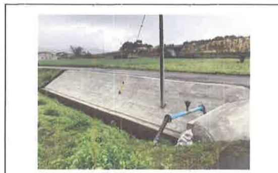
水路の補修工事 【長寿命化活動】
