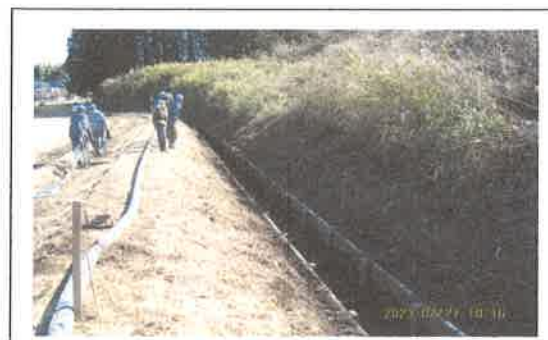
水路の更新工事 【長寿命化活動】
