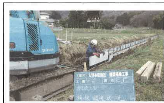
水路の柵渠工事 【長寿命化活動】
