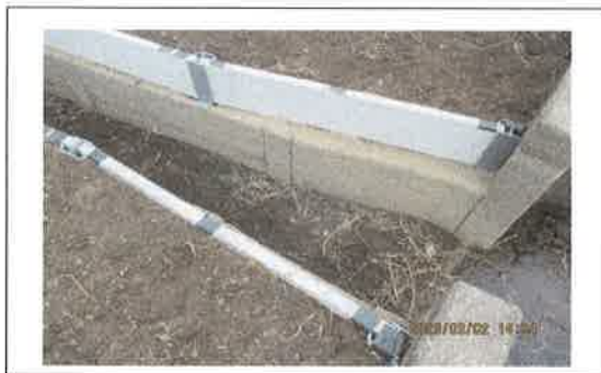
水路の嵩上げ工事 【長寿命化活動】
