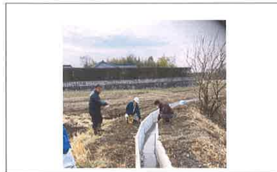
水路の更新工事 【長寿命化活動】
