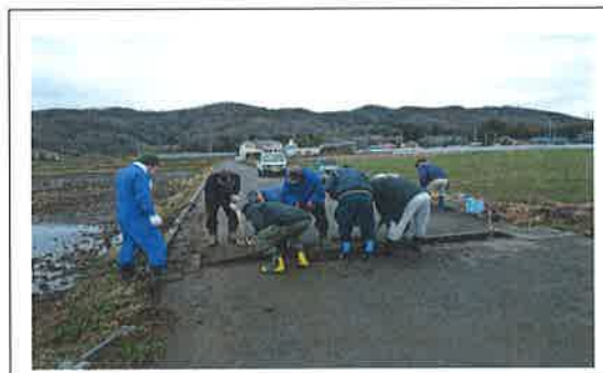
水路の軽微な補修 【共同活動】
