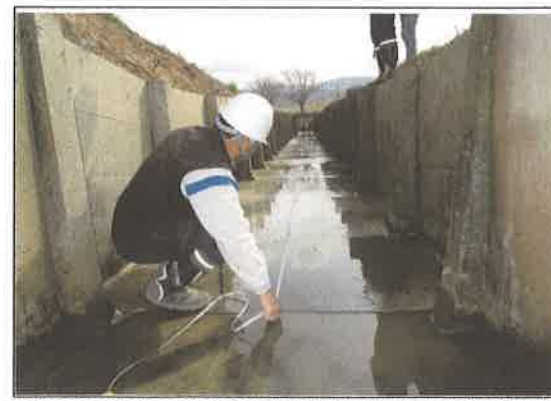
排水路底版コンクリート工事 【長寿命化活動】
