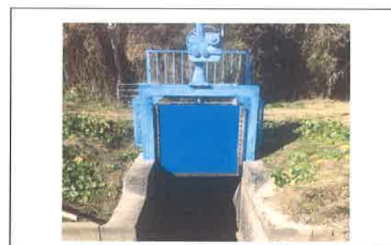
桜川用水排大型水門補修 【長寿命化活動】
