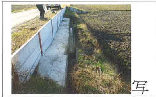
水路の軽微な補修 【共同活動】
