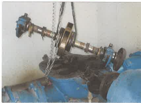
第二機場揚水ポンプシャフト整備 【共同活動】
