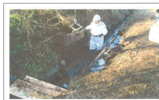
用水路、法面補修工事 【長寿命化活動】
