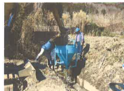
長寿命化 排水路補修工事
