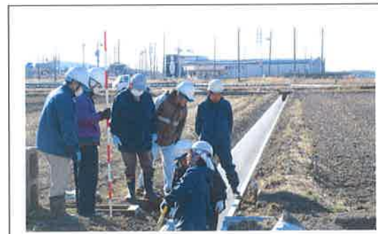
水路の更新工事 【長寿命化活動】
