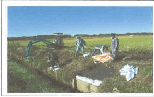
水路法面の軽微な補修 【共同活動】
