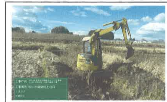
水路の破損補修工事 【長寿命化活動】
