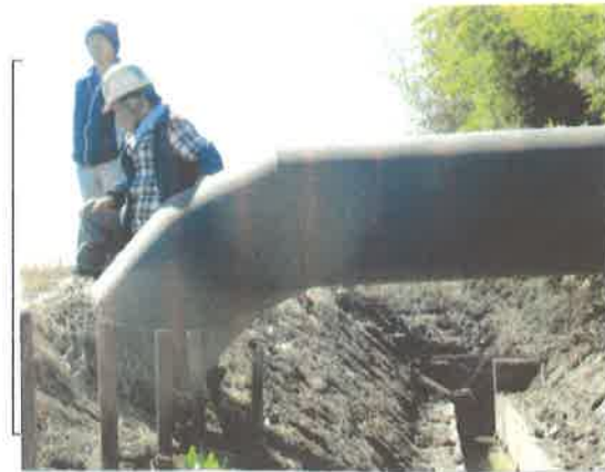
水路の更新工事 【長寿命化活動】
