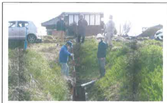
水路の点検 【農地維持活動】
