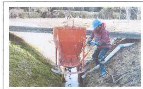
水路の底盤コンクリート工事 【長寿命化活動】
