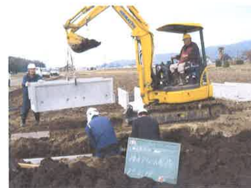
直営工事による水路の更新工事 【長寿命化活動】
