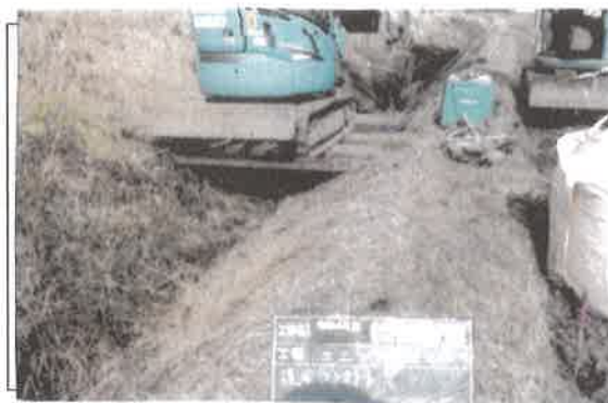
(例) 水路の更新工事 【長寿命化活動】
