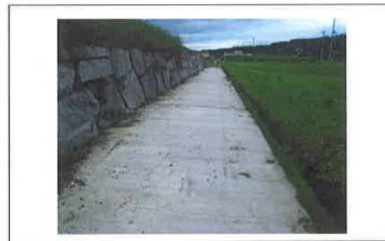
農道コンクリート舗装工事 【長寿命化活動】
