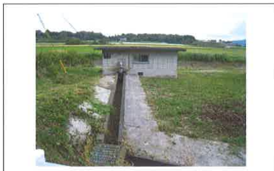
水路の軽微な補修 【共同活動】
