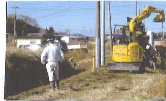
水路の更新工事 【長寿命化活動】
