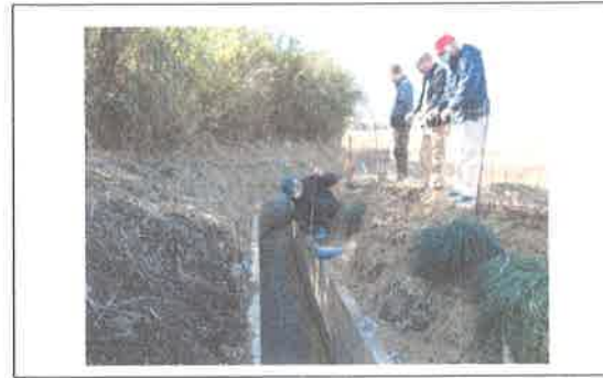
水路の更新工事 【長寿命化活動】
