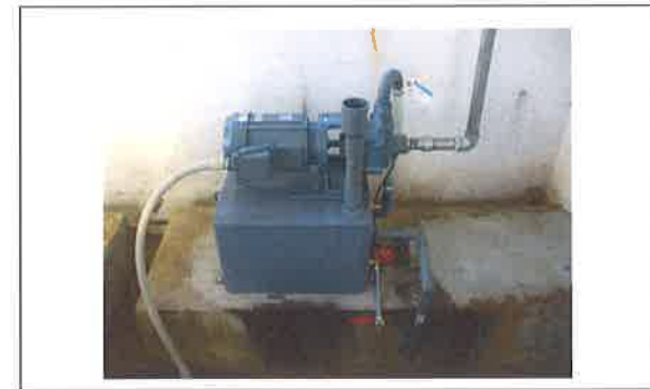
釜神地区機場の真空ポンプの更新 【長寿命化活動】
