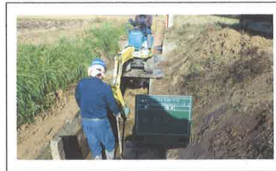
水路の底板コンクリート工事 【長寿命化活動】
