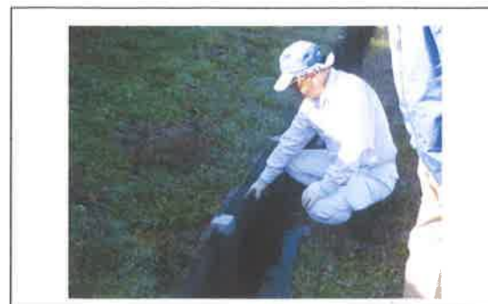
水路の補修工事 【長寿命化活動】
