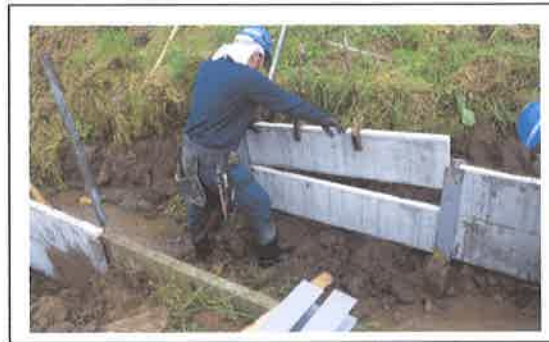
水路棚板設置工事 【長寿命化活動】
