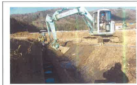
柵渠底盤コンクリート工事 【長寿命化活動】
