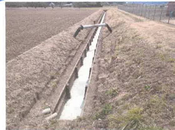
水路の改修工事 【長寿命化活動】
