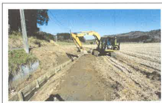
水路の更新工事 【長寿命化活動】
