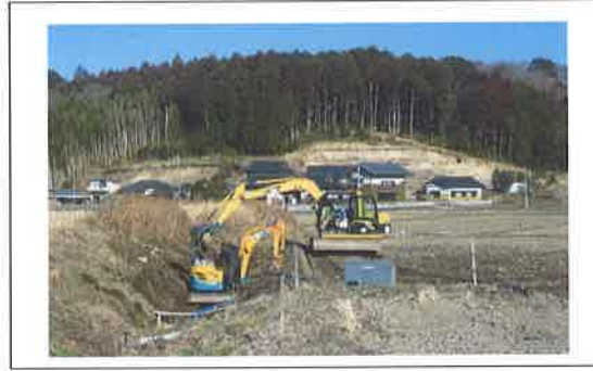
水路の更新工事 【長寿命化活動】
