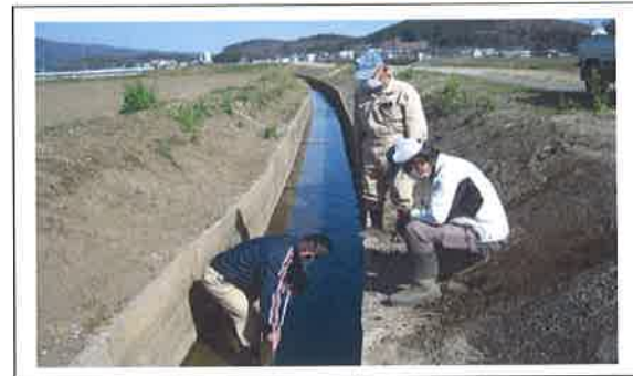
水路の更新工事 【長寿命化活動】
