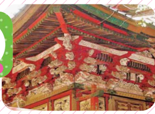
「富谷観音(施無畏山小山寺)」(とみやかんのん せむいざんおやまじ)の三重塔(室町時代建立)は、国の重要文化財
