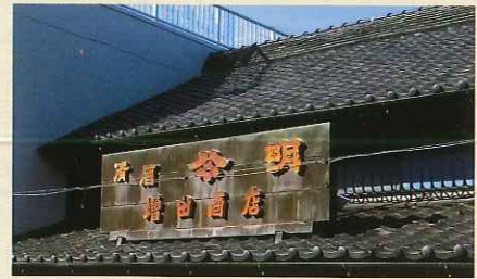
1階庇上の屋外広告物
