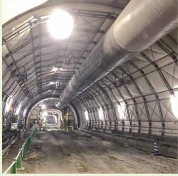
▼仕上げのコンクリート壁の養生作業状況(桜川工区)
