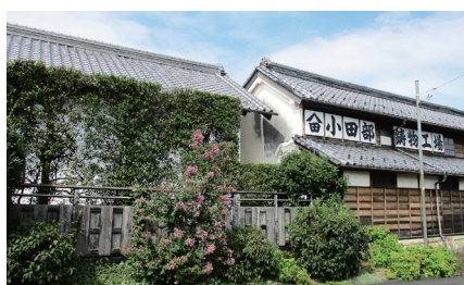
市街地内の鋳物工場
