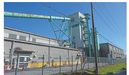
間中工業地区内の工場
