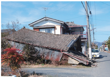
東日本大震災-倒壊した家屋
