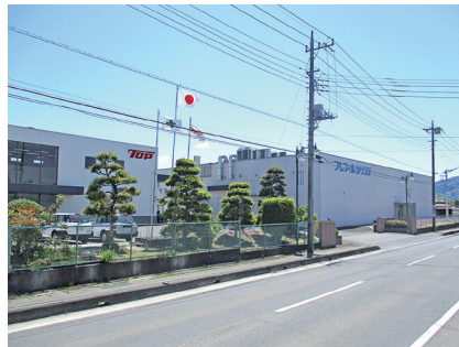
亀岡集落内の工場
