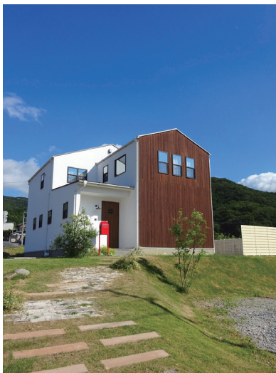
集落内の現代風建築(1)
