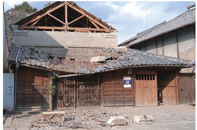
東日本大震災-崩落した石蔵
