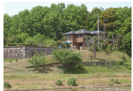
集落内の洋風建築
