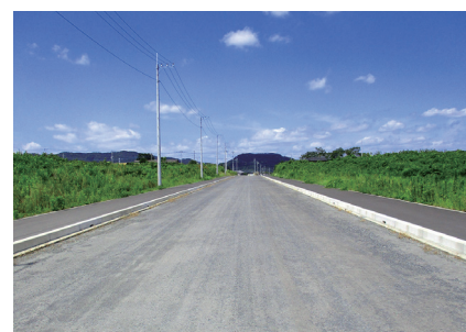
整備中の基軸道路（市道 0141 号線）
