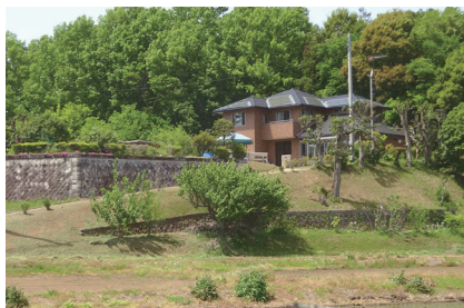
集落内の洋風建築
