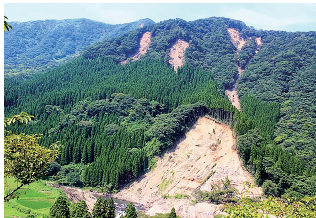
平成28年熊本地震による斜面崩壊
