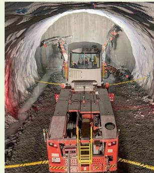
▼トンネルを掘削する大型重機「ドリルジャンボ」による作業状況（桜川工区）
