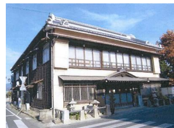
橋本旅館店舗修理 （歴史的風致形成建造物）
