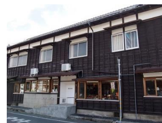
被災修理を経て喫茶店として開業した登録有形文化財
