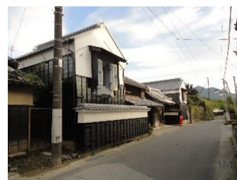
登録有形文化財の災害復旧 上：復旧前 下：復旧後
