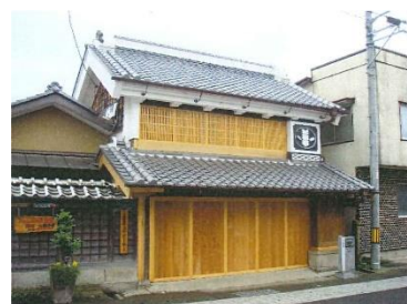
修復された見世蔵
