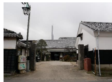
修復された村井醸造
