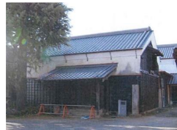
谷口家住宅穀蔵修理 （歴史的風致形成建造物）
