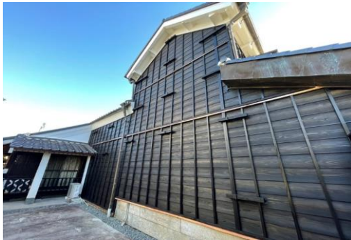
修理後の中村家見世蔵及び主屋
