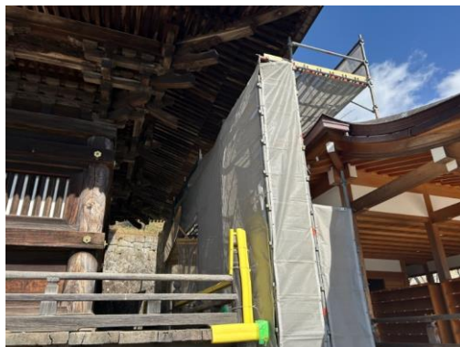
雨引観音楽法寺 雨樋設置工事
