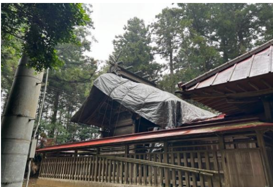
鹿島神社本殿 屋根養生工事
