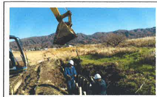
水路の更新工事 【長寿命化活動】
