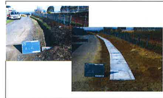
安全確保のための蓋設置工事 【長寿命化活動】
