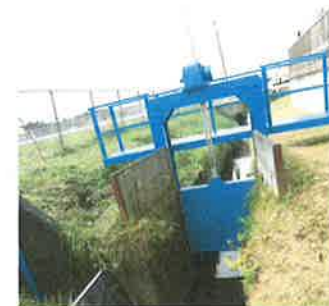
水路の更新工事 【長寿命化活動】
