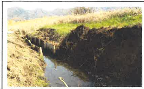
水路の軽微な補修 【共同活動】
