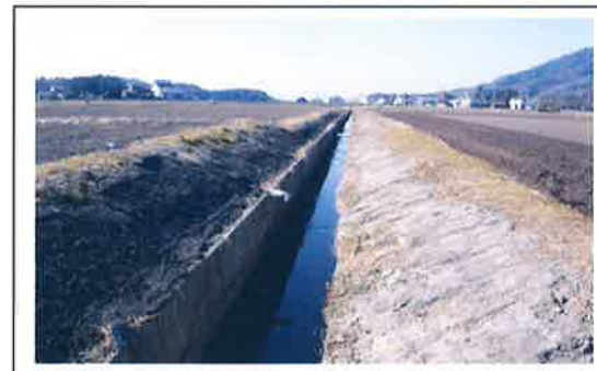
水路の底盤工事 【長寿命化活動】
