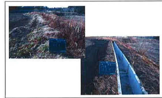
水路改修工事 【長寿命化活動】
