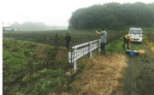
水路の軽微な補修 【共同活動】
