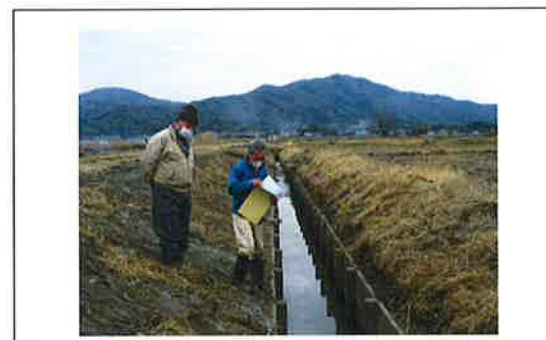
水路の更新工事 【長寿命化活動】
