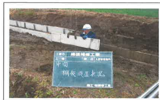
水路の柵渠工事 【長寿命化活動】
