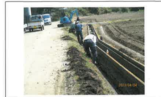
水路の泥上げ作業 【農地維持活動】
