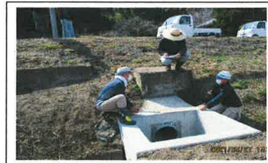
水路(集水柵)の更新工事 【長寿命化活動】
