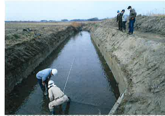
大排水路底版コンクリート工事 【長寿命化活動】
