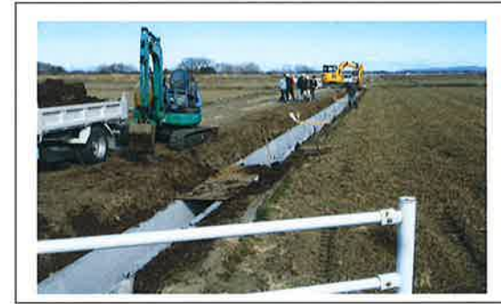
水路の更新工事 【長寿命化活動】
