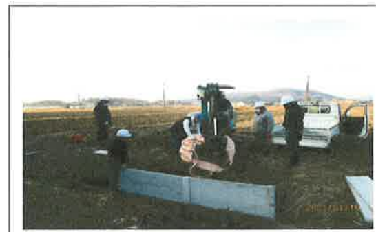
水路の更新工事 【長寿命化活動】
