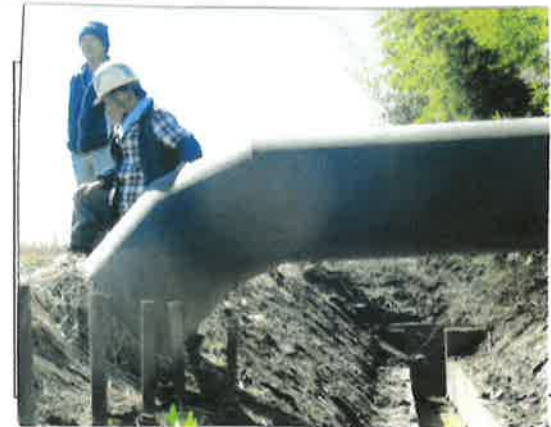
水路の更新工事 【長寿命化活動】
