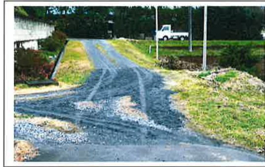
農道の軽微な補修 【共同活動】
