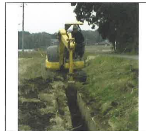
水路の破損補修工事 【長寿命化活動】
