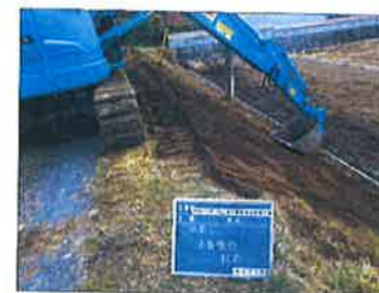
法面補修工事 【長寿命化活動】
