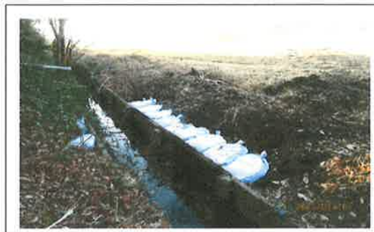
水路の軽微な補修 【共同活動】
