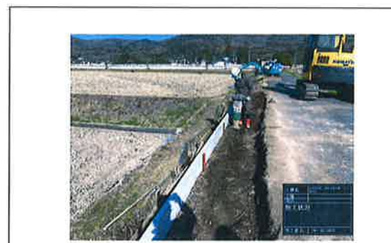
水路の補修工事 【長寿命化活動】
