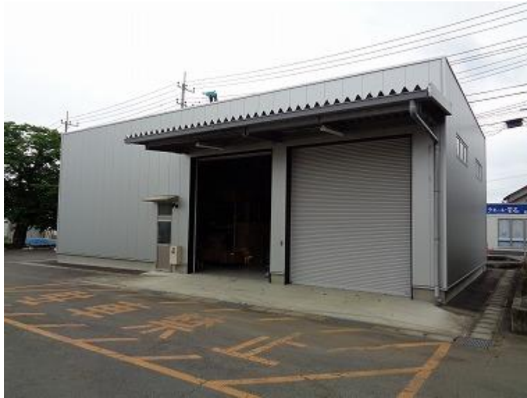
(写真は桜川市防災備蓄倉庫)
