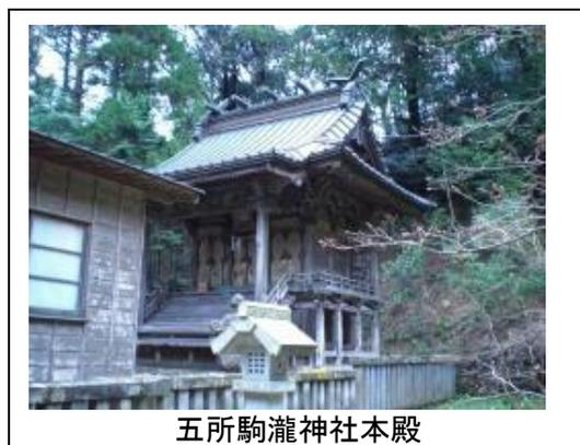
現在の本殿は、入母屋造銅板葺、三間社流波風造で、宝永元年(1704)古城村(現桜川市真壁町古城)の大工増渕清兵衛を棟梁として再建されたものである。
