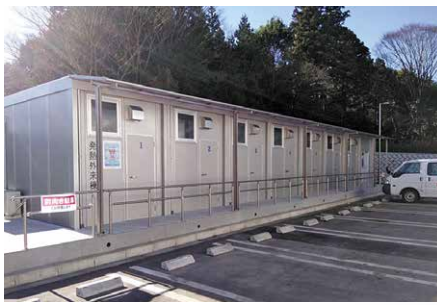
完成した外来棟
