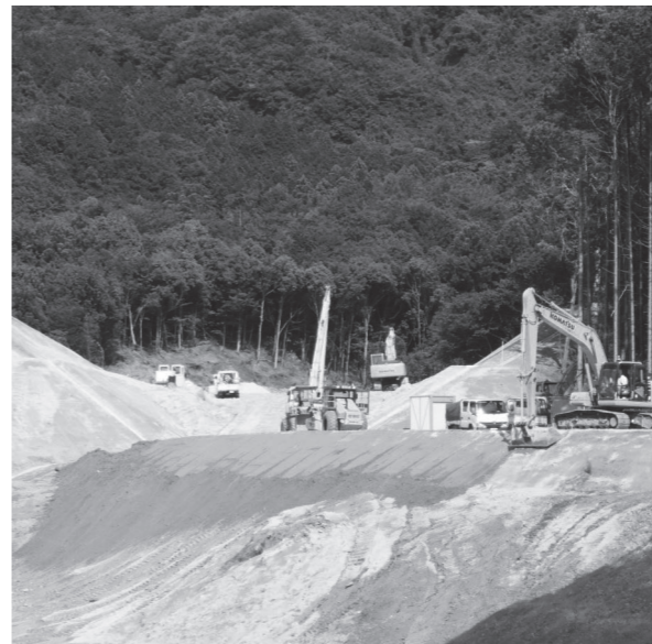
上曾トンネル工事 (真壁町山尾地区)
