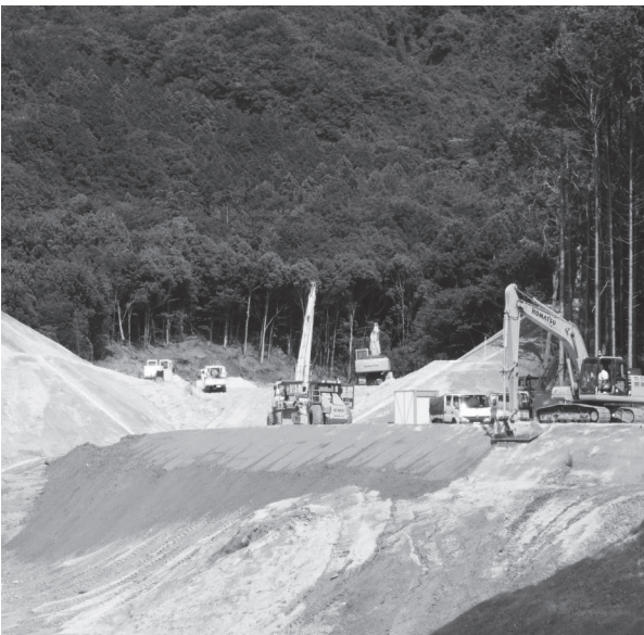
上曾トンネル工事（真壁町山尾地区）
