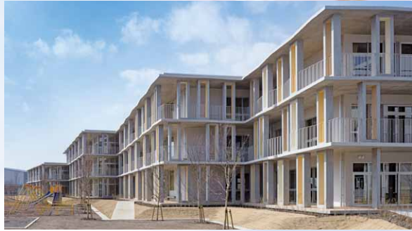
完成した新校舎
