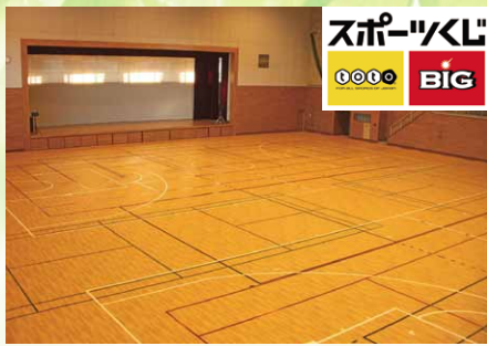
床改修工事が完了したメインアリーナ
