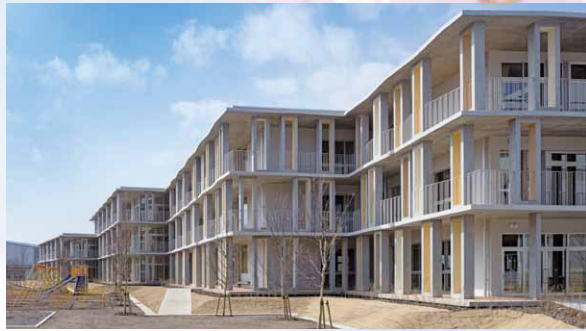
完成した新校舎
