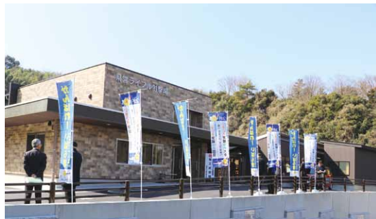
3月に完成した茨城県営ライフル射撃場
