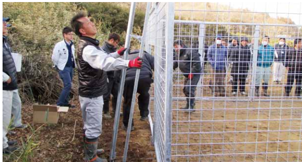
納入業者から囲いわたの説明を受けながら設置する参加者
