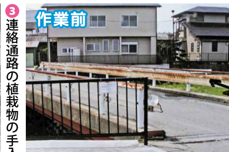
2 桜川河川の橋ガードレールのさび落とし・塗装
