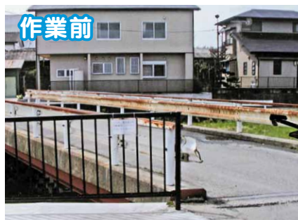
2 桜川河川の橋ガードレールのさび落とし・塗装
