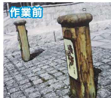
1 連絡通路ガードポールのさび落とし・塗装
