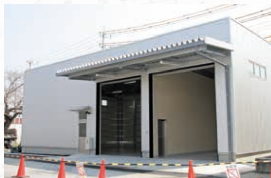
建設中の大型備蓄倉庫
