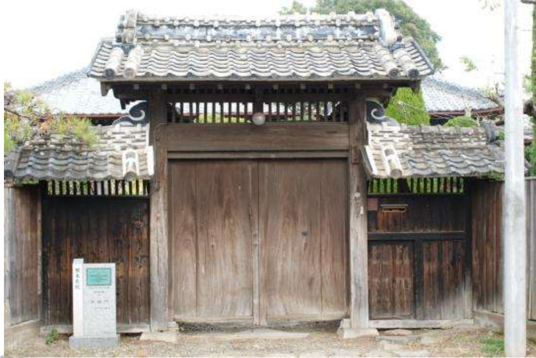
主屋正面に建つ高麗門 (下宿通り・根本家)
