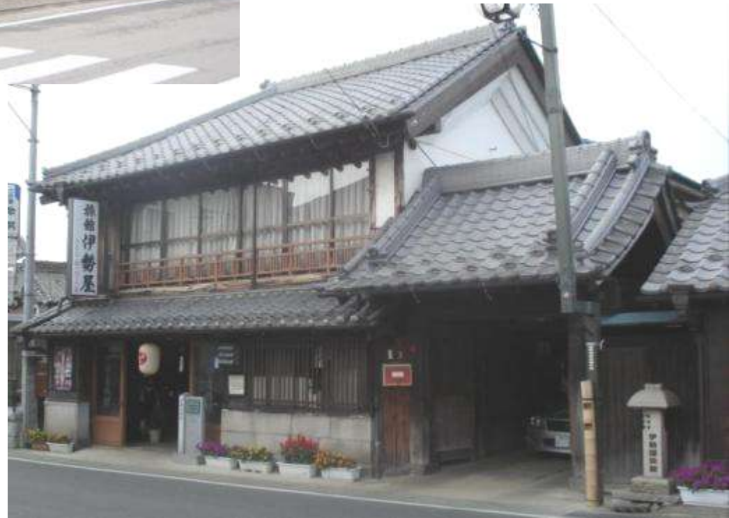
主屋の脇に接続する薬医門 (下宿通り・伊勢屋旅館)
