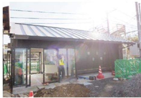
作業中。全体完成は、3月末予定です。
